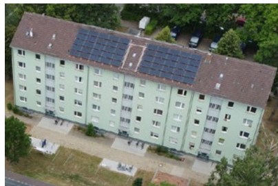
Abb. 59 und 60: Gebäude mit PVT-Anlage auf dem Dach in Ost-West-Ausrichtung
