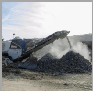
Recycling Brechen & Sieben
