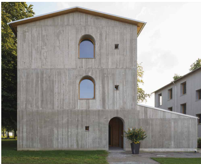
Forschungshaus aus Infraleichtbeton: Der Rohbau besteht aus 50 cm dicken, einschaligen Außenwänden. Foto: B&O-Gruppe
